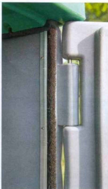
Die Türen sollten mit so genannten Bürsten-Dichtungen versehen sein. Das verhindert das Festfrieren.
